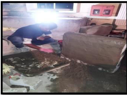
Fig: Normal plaster
